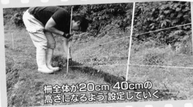
画像2 誰かが線を張った直後に、別の人が目安棒でチェックするとよい。とくに段差のあるところでは線が高く持ち上がりがちなので要注意
